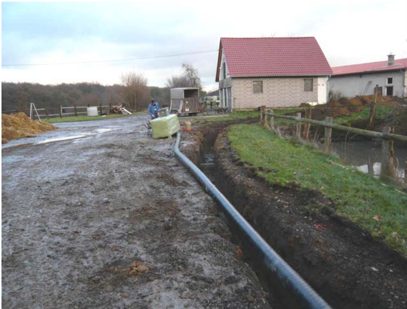
Die 165 m lange Wärmeleitung.
